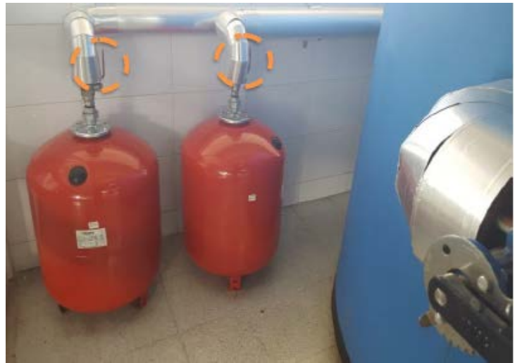
Estanques de expansión
